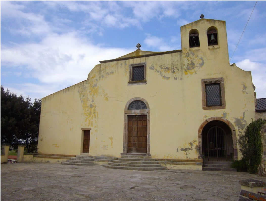
Foto Facciata Principale della Chiesa oggetto d'Intervento.
