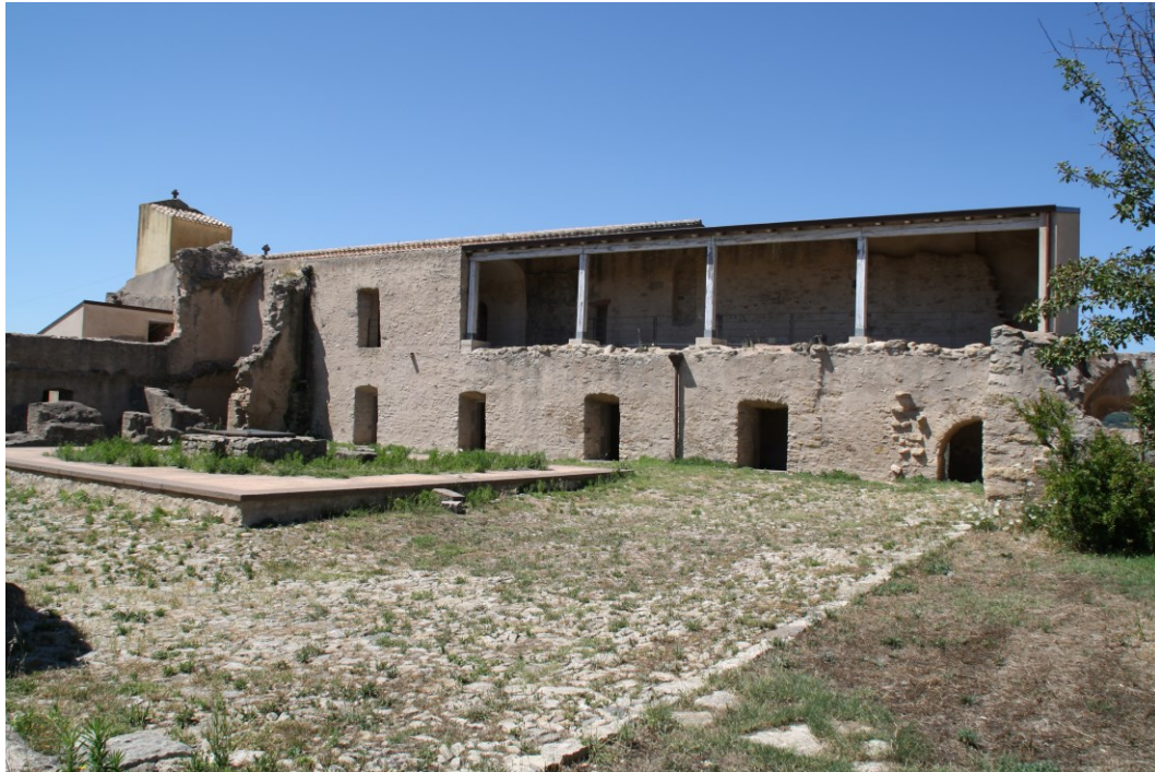
Foto del Prospetto sui ruderi dell'ex Convento
