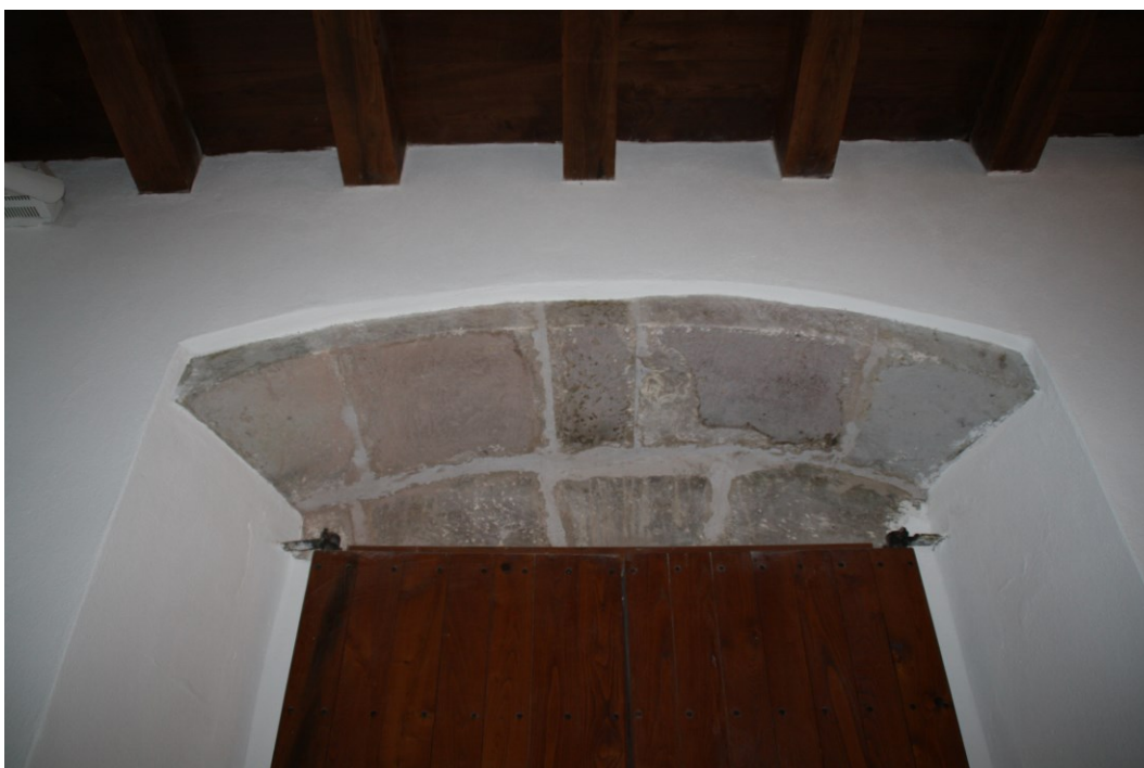
Foto dettaglio della piattabanda prima e dopo l'intervento di Restauro
