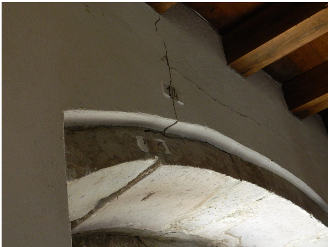
Foto dettaglio della piattabanda prima e dopo l'intervento di Restauro
