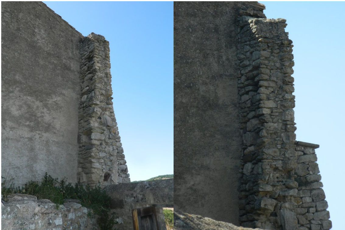
Foto dettaglio del contrafforte oggetto d'intervento
